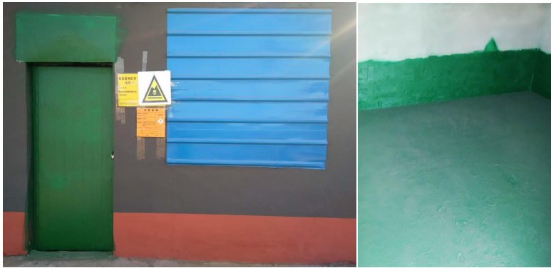
图 4-3 项目危废暂存间现场照片
